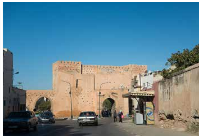
Oók nog even door Meknès
